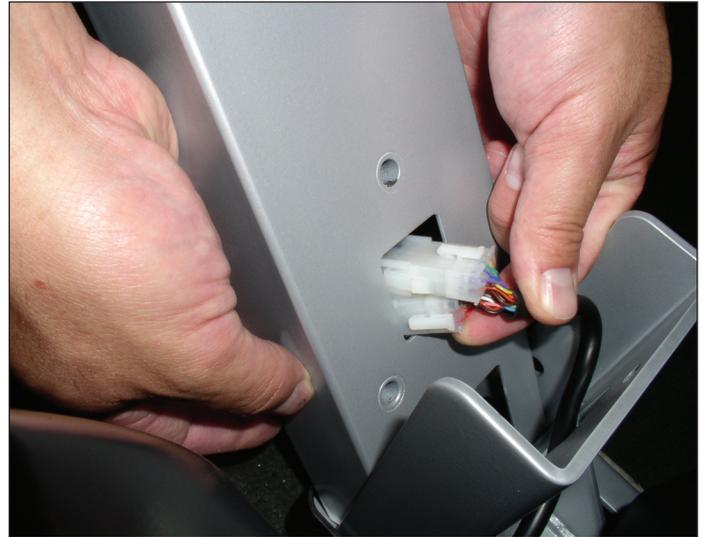
Individuare il MONTANTE DESTRO (4). Il montante è contrassegnato da una "R". Posizionare il MONTANTE DESTRO vicino alla parte interna della staffa destra. Installare tutta la bulloneria e per ora avvitarla manualmente. Fissare il MONTANTE DESTRO alla staffa destra con tre BULLONI ARGENTO M8 x 60 mm (2) e tre RONDELLE A STELLA (3). Fissare la parte anteriore del montante usando un BULLONE ARGENTO M8 x 15 mm (9) e una RONDELLA A STELLA (3).
