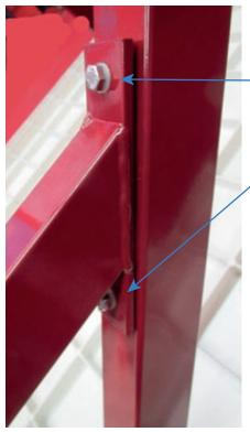
Schraube / Screws M 6 x 65, Mutter / Nut SM M 6 Plastik-U-Scheibe / Plastic washers 6,4
